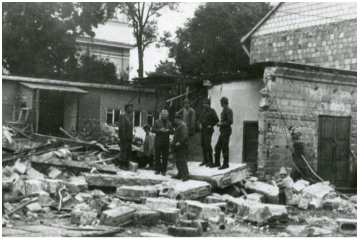
Prace rozbiórkowe. Kronika OSP w Suchowoli
