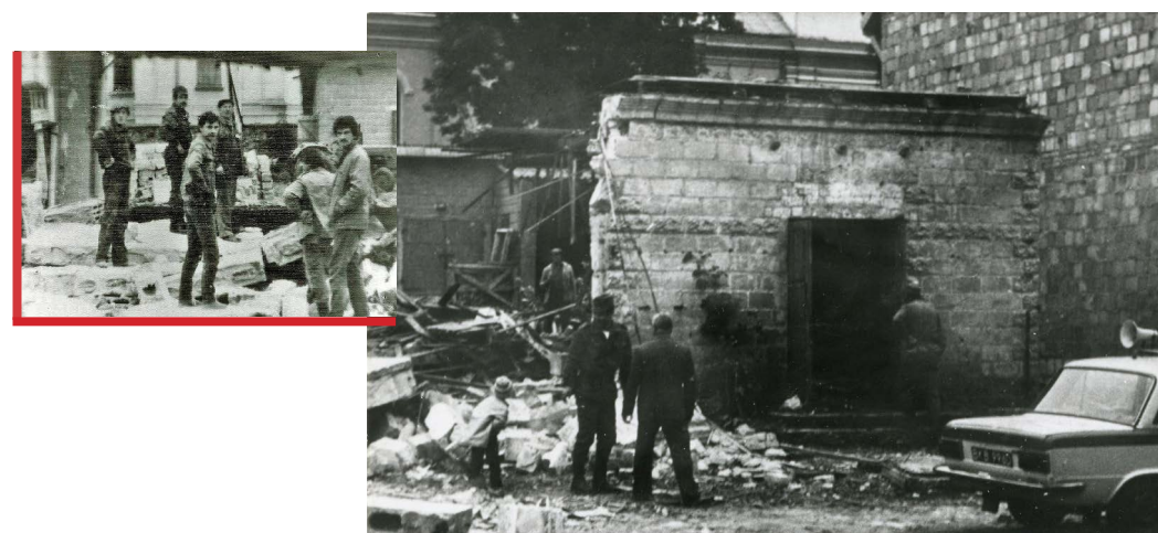
Prace rozbiórkowe. Kronika OSP w Suchowoli
