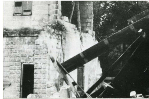
Prace rozbiórkowe. Kronika OSP w Suchowoli
